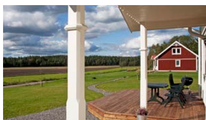
B PROFILERAD PELARE MED KRANS
